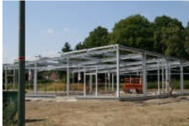
An der Robert-Bosch-Straße entsteht auf 2000 Quadratmetern eine Klinik für Kleintiere. (Foto: Ingel)
